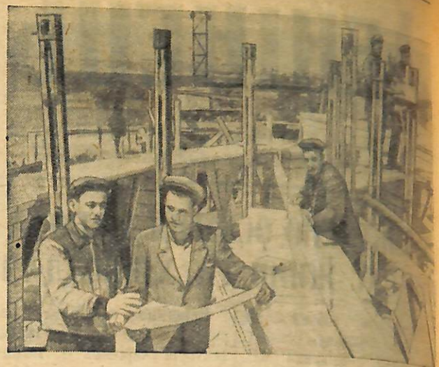
В м. Нова Каховка закінчується будівництво літного театру на 820 місць. НА ЗНІМКУ (на передньому плані): техник-комсомолец М. КАПЛАН (ліворуч), який нещодавно закінчив Київський технікум цивільного будівництва, і бригадир плотників комуніст Г. ВІРИЧ на будівництві театру. Фото А. Фатєєва. (Прескляше ПАТАУ)
