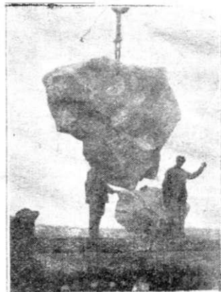
Подъемка „изюмшвы“ с платформы дерриквым краном.
