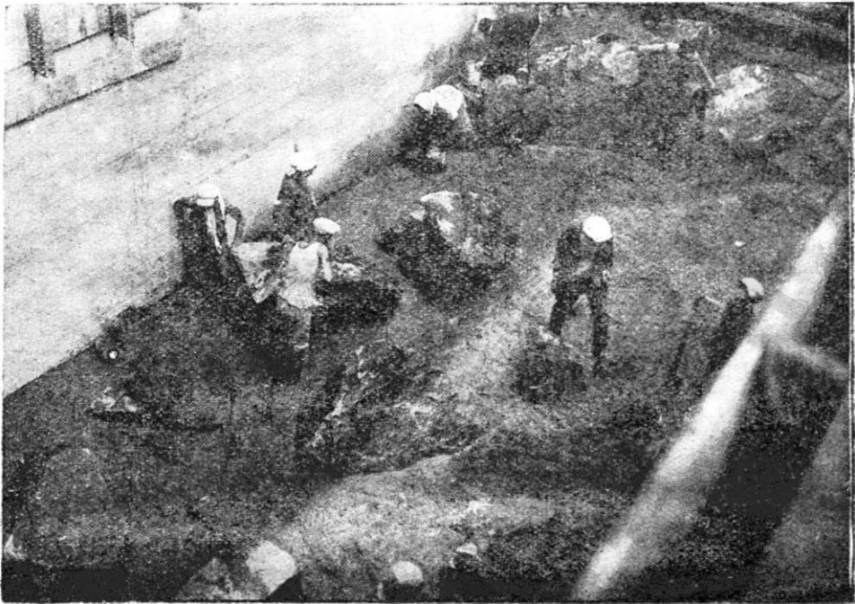
Укладка „изюма“ в бетон
