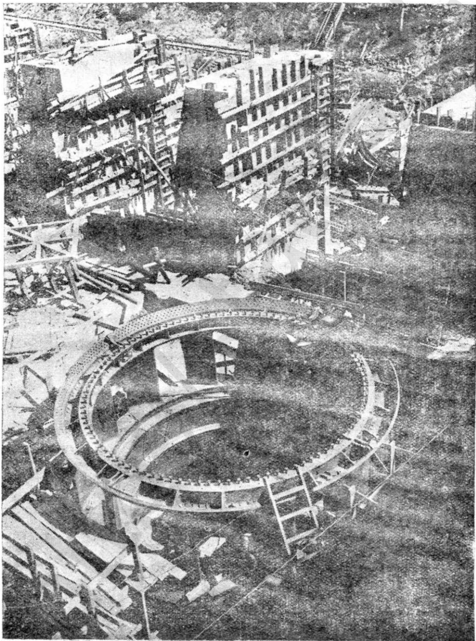
В котловане Гидростанции. Собранный скоростное кольцо одной из турбин.
