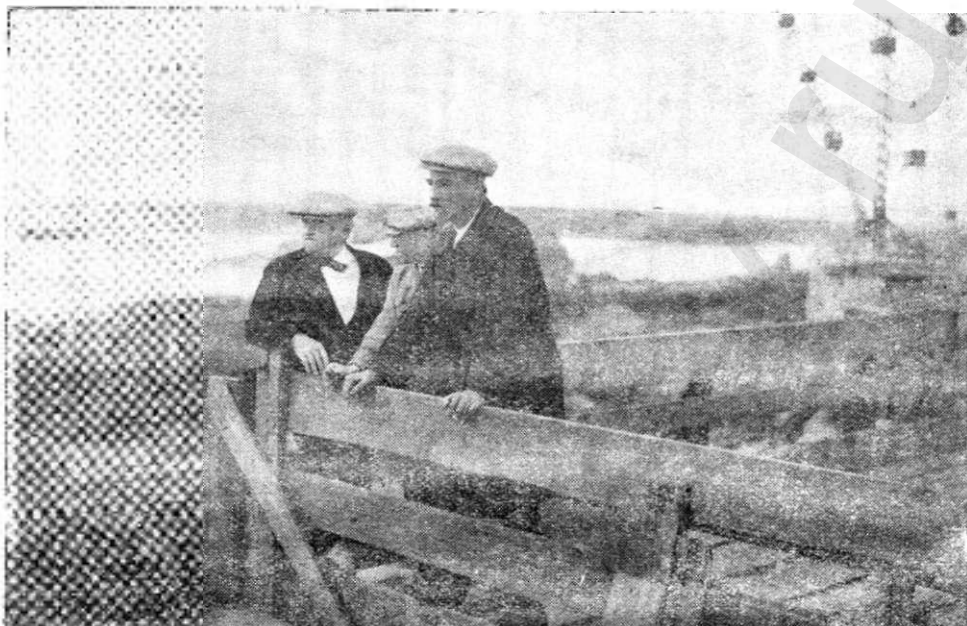
Начальник Строительства А. В. Винтер (справа) и приехавший в августе из Нью-Йорка глава американской консультации инж. Кулер (слева) осматривают работы.
