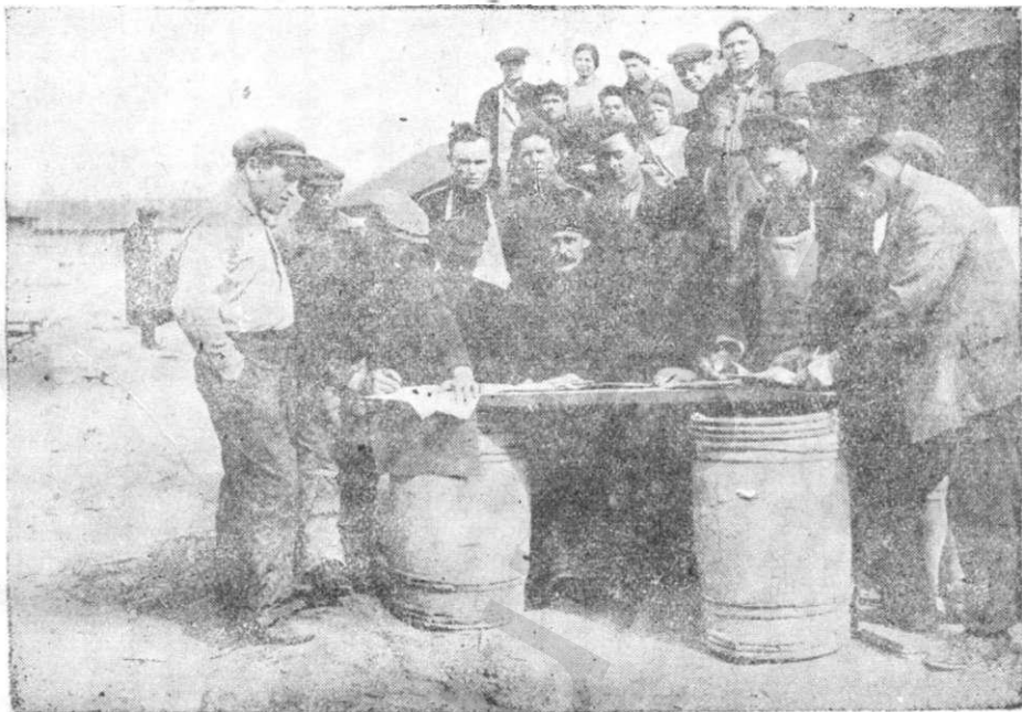
Рабочие—ударники Днепрозаводстроя подписывают на месте работ договор социалистического соревнования.
