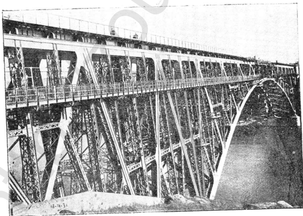
Общий вид кичкасского моста перед началом его разборки.
