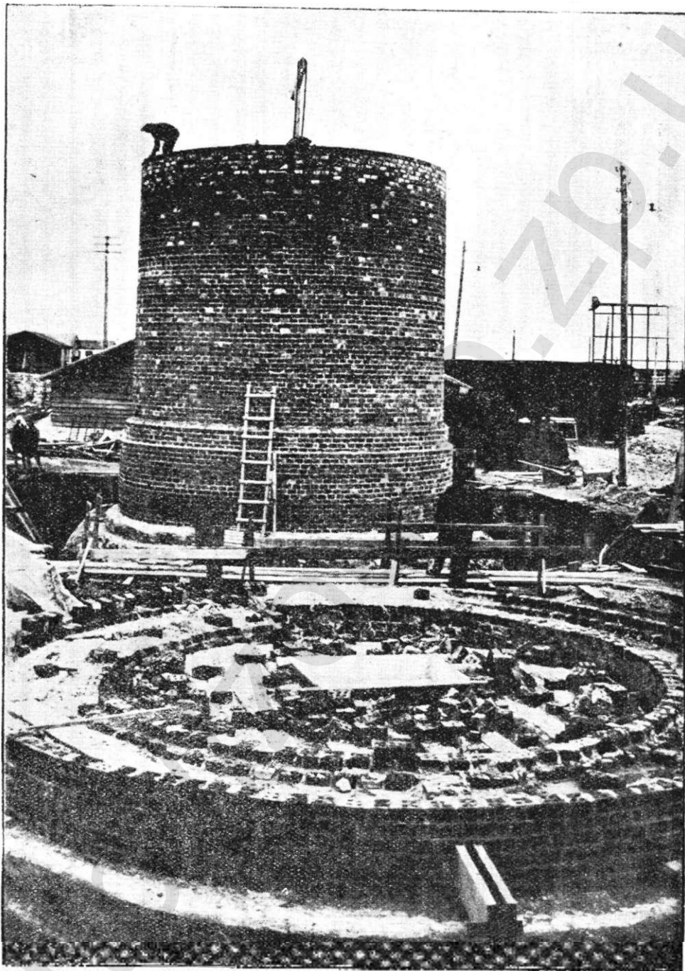
Днепрокомбинат. Кладка дымовых труб Коксохимического завода.
