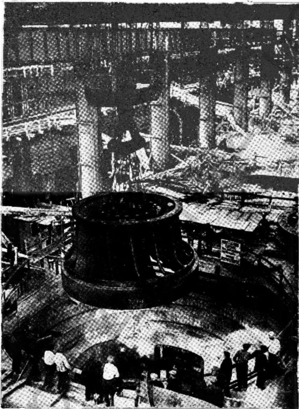
ГЭС. Установка на место рабочего колеса турбины.
