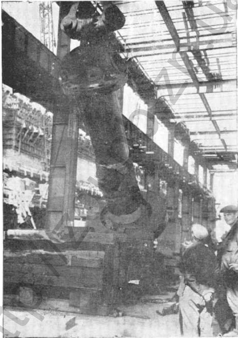
ГЭС. Установка вертикального вала агрегата.
