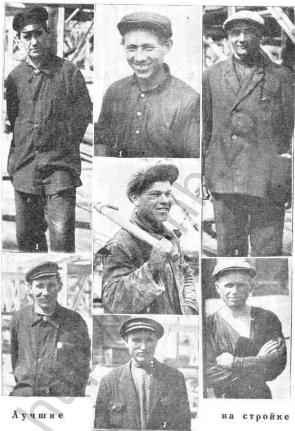
1. Т. Хайрулин Зейдула Х. бригадир—групповод, перевыполнивший задание на работах по загрузке бункеров 1-ой домны на 265%. 2. Слесарь-ударник ЦММ т. Петренко С. И. 3. Ударник паровоз. бригады ЦММ т. Мочалов. 4. Ударник-бетонщик т. Гребенюк М. И. (Днепросталь). 5. Ударник котельн. цеха ЦММ т. Коновец В. Я. 6. Ударник паровой бригады ЦММ т. Полуцыганов В. И. 7. Ударник-котельщик ЦММ тов. Христин В. И.
