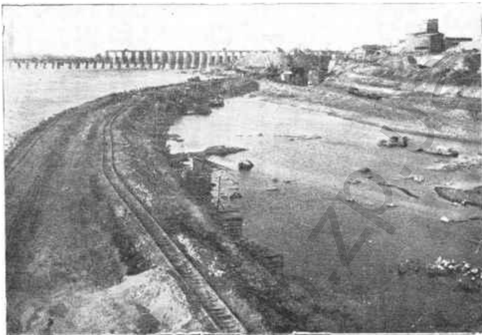
Дамба низового подхода к шлюзу. Вид со стороны скалы „Дурная“
