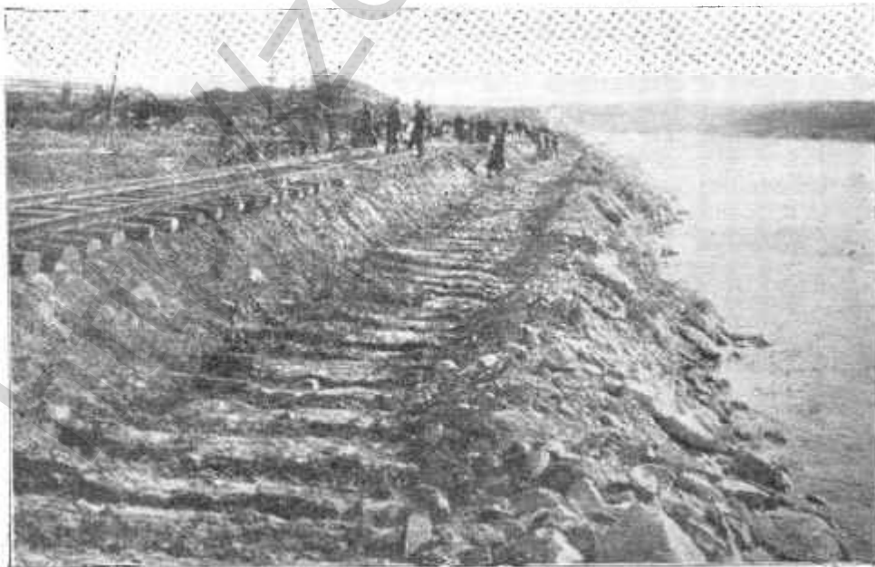
Наращивание земляной дамбы на низовом подходе к шлюзу (29 апреля с. г.).
