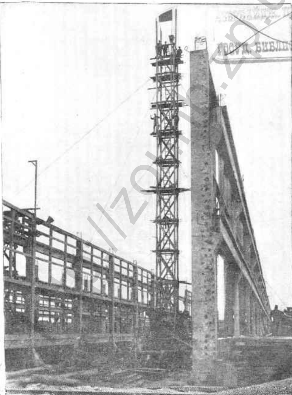
Установка бетонной башни на постройке алюминиевого комбината
