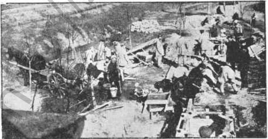
Бетонировка фундаментов под мачты линии передачи 161 киловольт.
