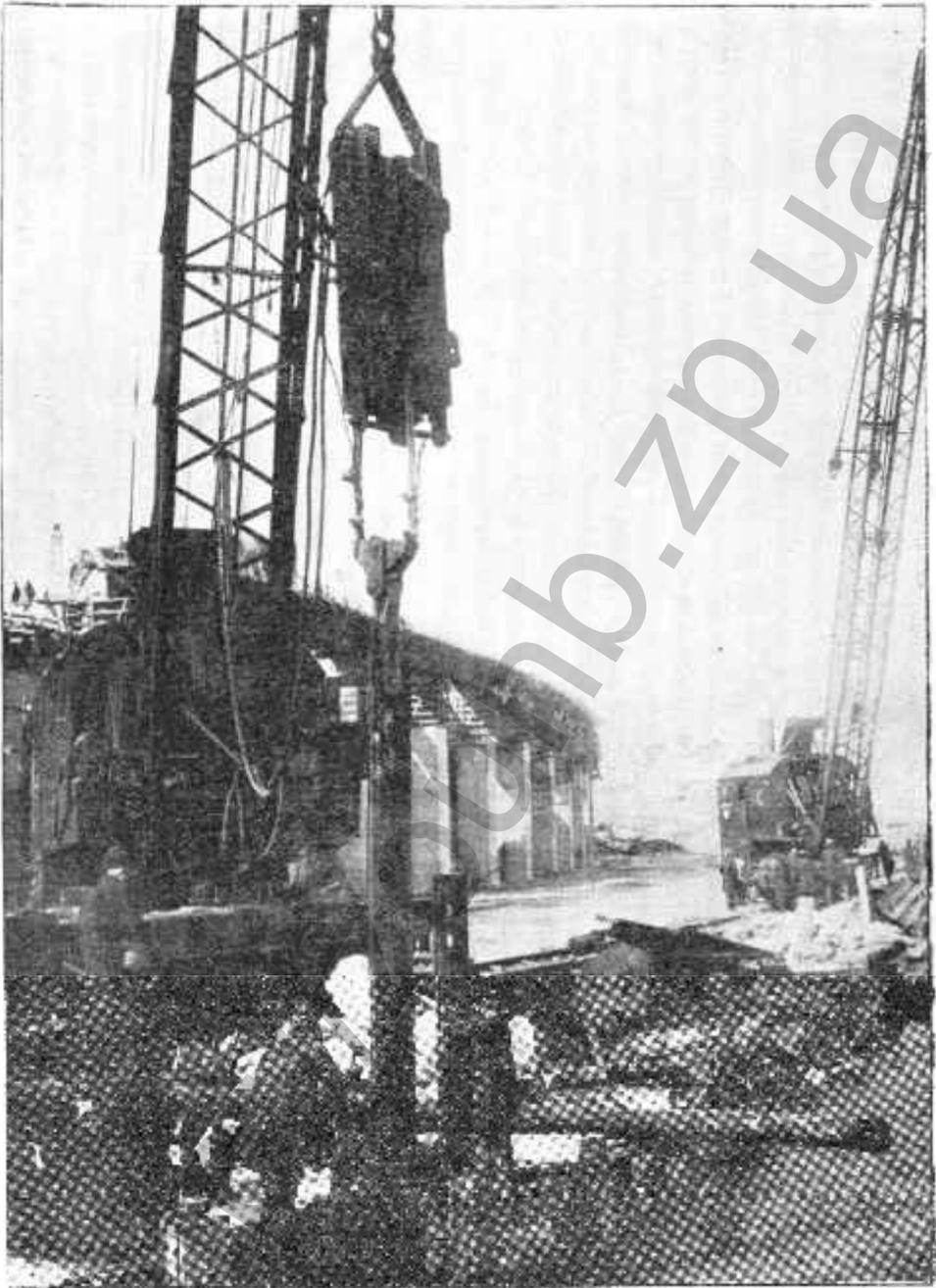
Выдергивание стального шпунта паровыми кранами на верхней перемычке плотины.
