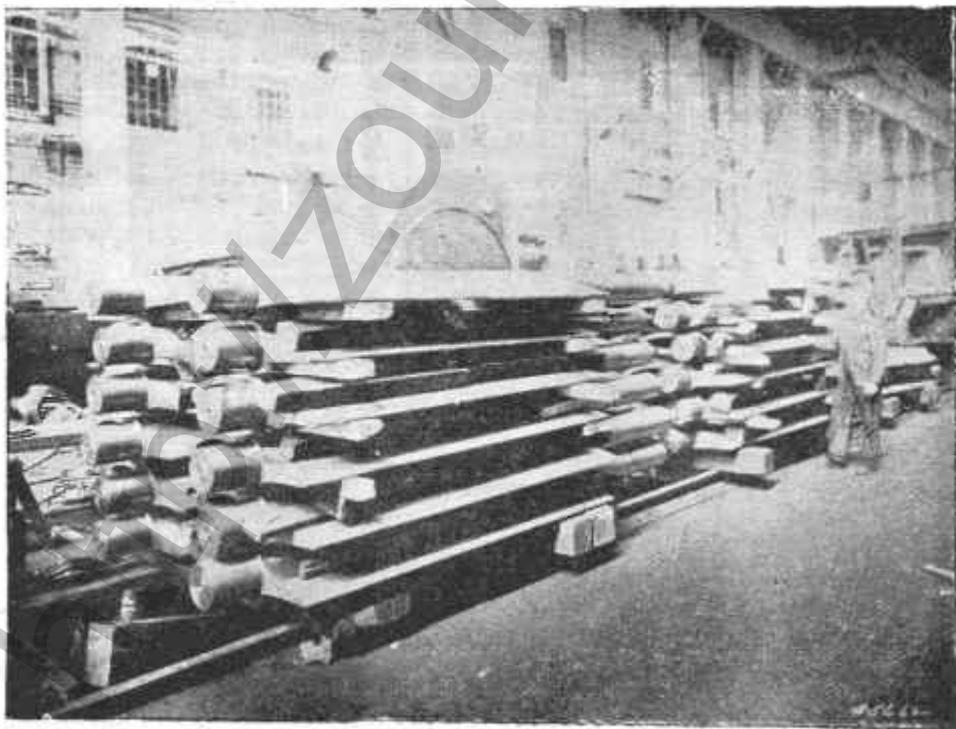
**Регулирующие лопатки турбин, изготовляемых на заводе Нью-порт-Ньюс (САСШ) для Днепровской Гидростанции.**
