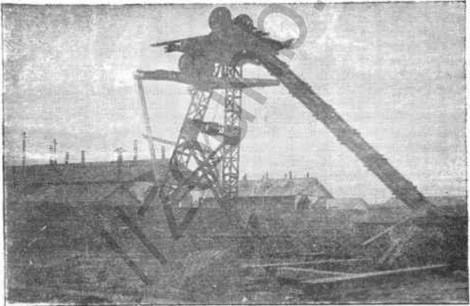
Сборка 80-тонного крана для разгрузки прибывающего водой оборудования для монтажа Гидростанции.
