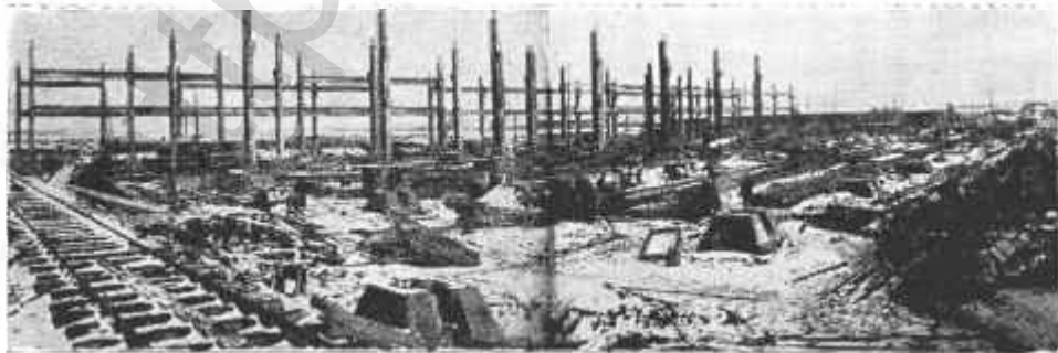
На стройке Аллюминиевого комбината. Сборка ж-бетонного корпуса электролитного завода.
