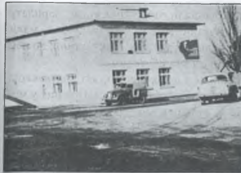
Адміністративне приміщення ЗАТ "Агрошляхсервіс"
