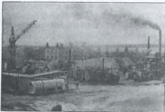
Панорама асфальтобетонного заводу
