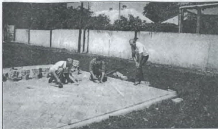
Іван Кирилович МАХИНЯ, Іван Прокопович КРУГЛІЙ і Анатолій Васильович КАСЯНЕНКО укладають тротуарну плитку на території машинобудівельного заводу
