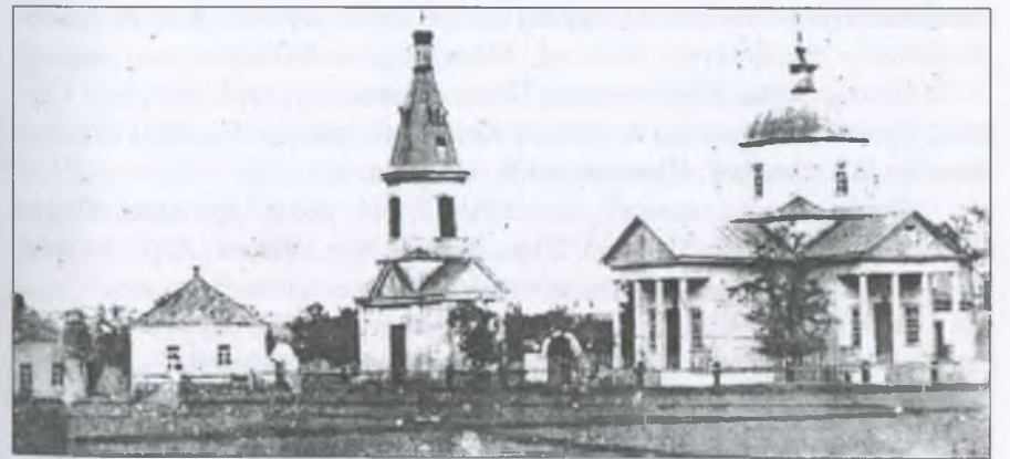
Церква в с. Санжарівці. Побудована в 1824 р.
