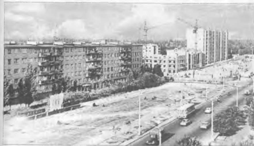
Мелитополь: новый микрорайон строится. 1982 год
