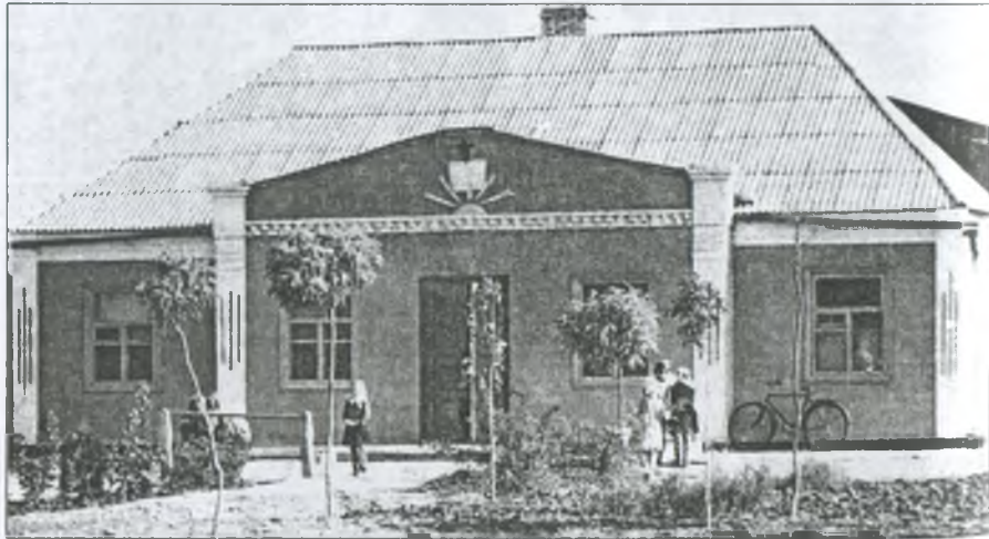
Приміщення колишньої початкової школи. 1961 р.
