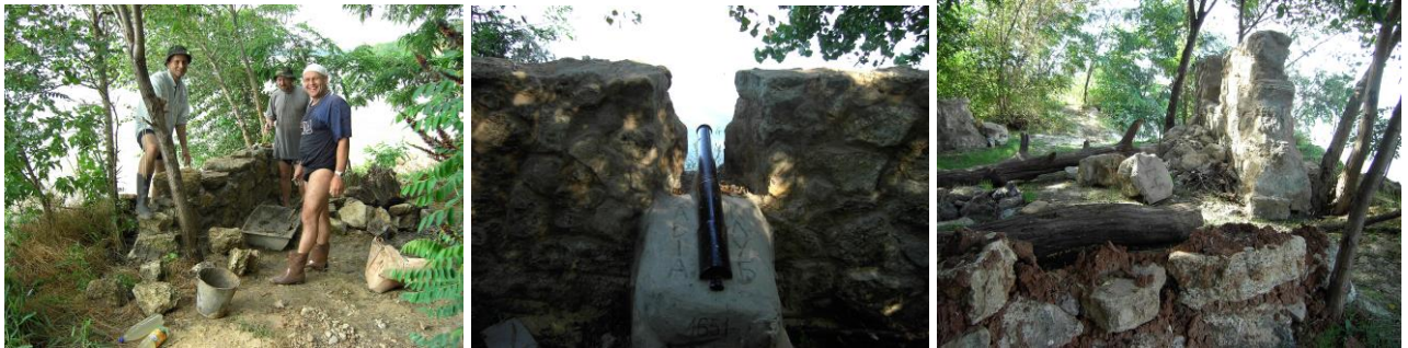
Фото 70.9. Будівництво і крах козацької фортеці-січі на Лисій Горі (мис Форт)
